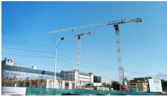
Obrázek 20. 6. 2025: Stavba nového komplexu; Pohled z ulice I.P. Pavlova zleva doprava: budova urgentního příjmu, klinika oční a ORL, klinika onkologická, klinika nemocí plicních, vpravo od jeřábu 3. interní klinika.
